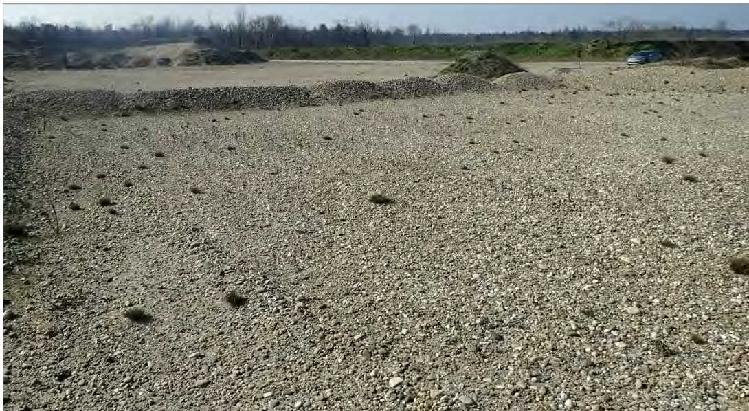
Abb. 1: Im Vorgriff zum Abbau beräumte Fläche, die zur Lagerung und Montage der FPV-Anlage genutzt werden soll (02.03.2023)
