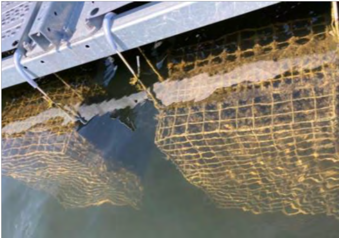
Abb. 18: Unter einer FPV-Anlage angebrachte Gitterkörbe für Fische (Quelle: BayWa)
