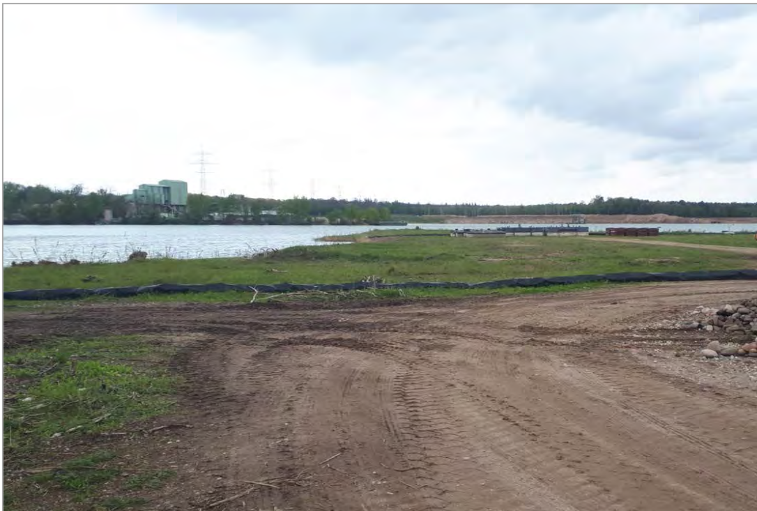
Abb. 15: Geplante Lager- und Montagefläche für die PV-Anlage (24.04.23)
