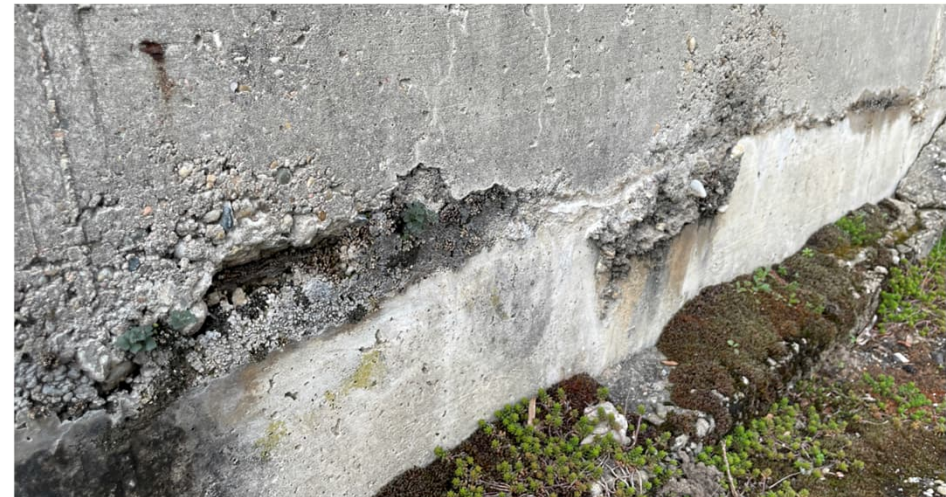
Abplatzungen Stützmauer
